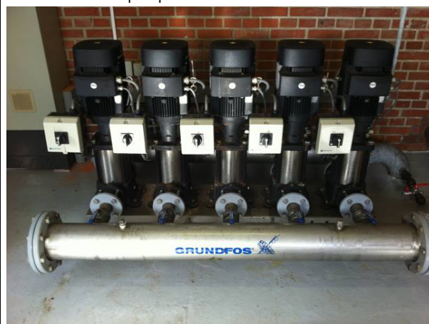
Foto af rentvandspumper
