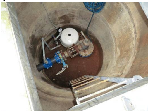
Boring DGU nr. 159. 1187
