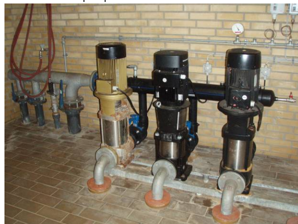
Foto af rentvandspumper
